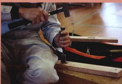
木造建築(在来軸組構法)における基礎・専攻学科と併せて器工具・機械操作等の使用方法を学び、製図、工作、施工等の実習を行い、小規模木造建築施工ができる実践的な技能を習得します。
